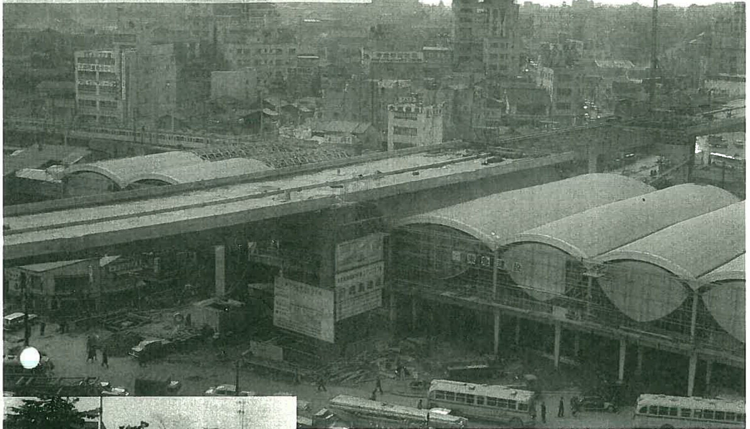
昭和 39 年 建設中の高速道路と東横線渋谷駅
