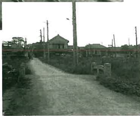
昭和 13 年 小栄橋(現在の中野通り付近) 東京都建設局所蔵
